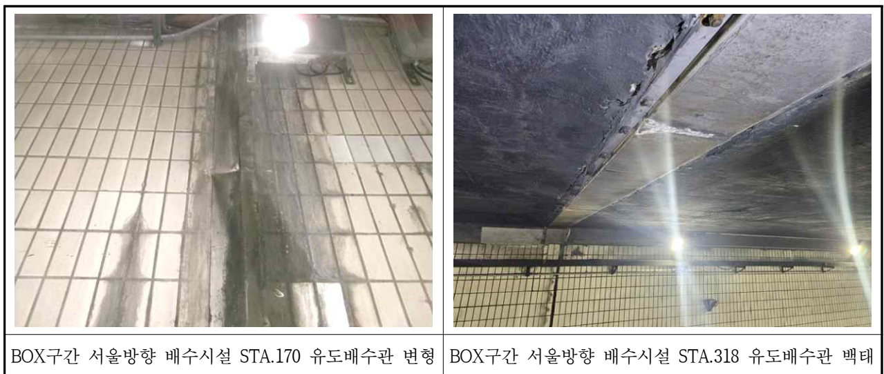
【사진 3.2.11】 배수시설 외관조사 결과
